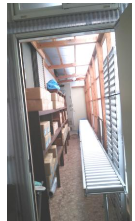
資材倉庫 （ローラーコンベア設置）
